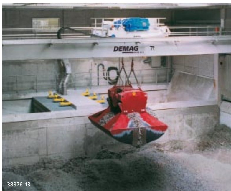
Macarale automate de proces Demag in cadrul procesului de fabricație din fabricile de ciment
