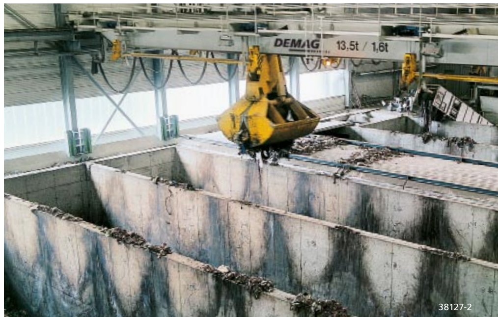
Macaralele de proces Demag asigură automat încărcarea buncărelor cu deșeu rezidual, într-o instalație de evacuare a deșeurilor
